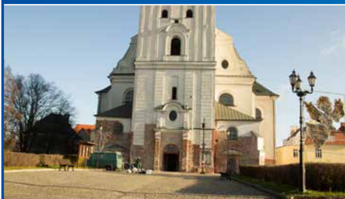
Rozpoczął się remont kościoła pw. Św. Jadwigi Śląskiej. Trwa osuszanie fundamentów i ścian.
