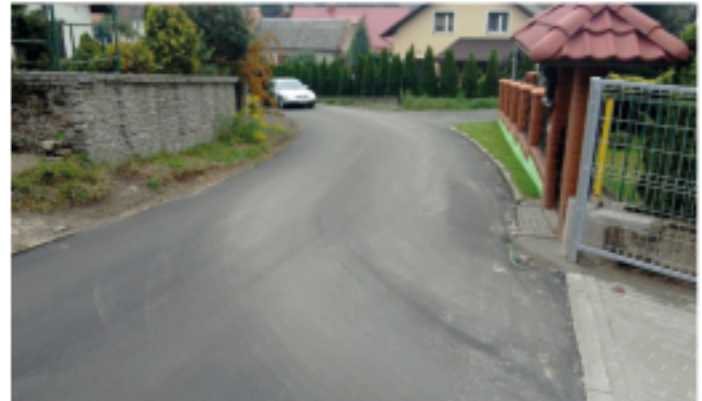
Droga dojazdowa do Przedszkola nr 4 spełnia swoje zadanie. Jest równo i bezpiecznie.
