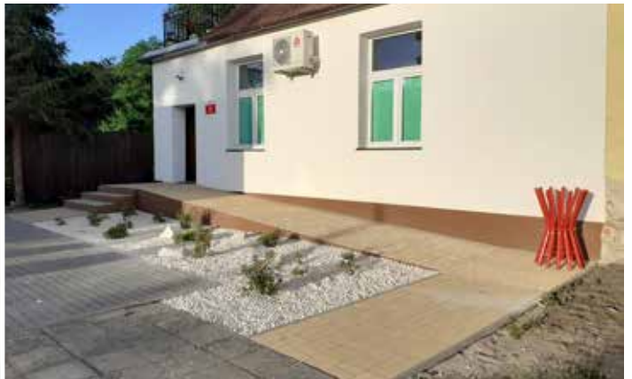
Świetlica w Kamieniu po gruntownym remoncie. Prace wykonano przy współpracy Gminy i Sołectwa.
