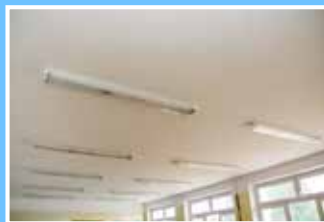
Wymiana instalacji elektrycznej - etap 2 - w Szkole Podstawowej nr 2
