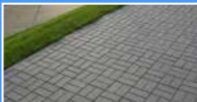
Zakup kostki brukowej na chodniki w Osiecznicy, Nowym Raduszu, Starym Raduszu, Bielowie i Sarbii
