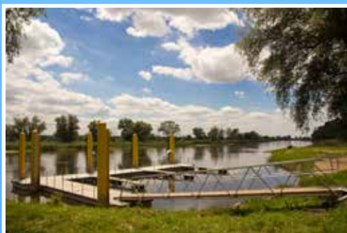
Budowa przystani w Gościorzu
