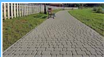
Budowa chodników w miejscowościach Węzyska i Czarnowo poprzez zakup kostki brukowej
